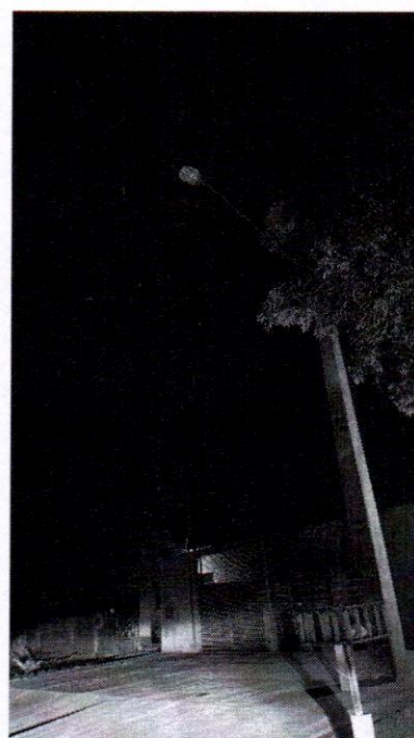
Ponto de iluminação pública sem funcionamento adequado no período noturno.
