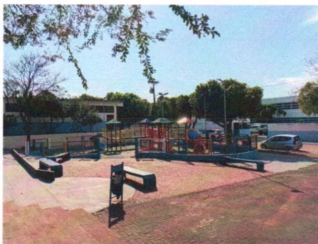
Foto 2 – Trecho entre a Casa do Papai Noel e o parquinho, com necessidade de adequação para garantir acessibilidade.
